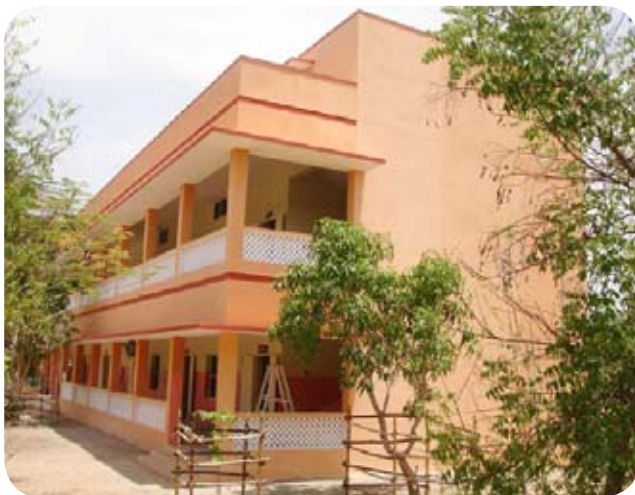
Der Neubau der Schule für die Grundschüler
