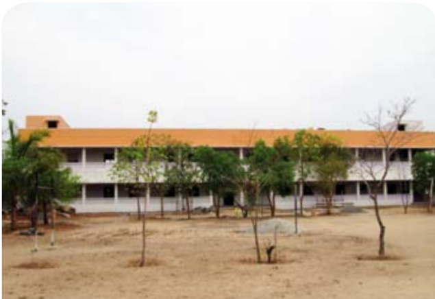
Das fast fertig gestellte neue Schulhaus Ende April.
